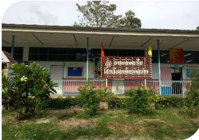
รูปที่ ๒ โรงเรียนบ้านคำสว่าง
